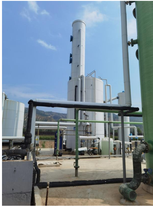
图2-4 沼气脱硫塔
