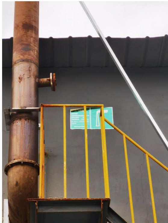
废气排口采样平台
